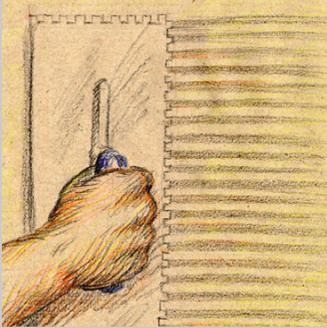
Die Platten entsprechend der Wandfläche zuschneiden. Der geeignete Untergrund wird mittels Spachtel oder Pinsel gleichmäßig möglichst dünn mit Innen- bzw. Außenkleber beschichtet.
